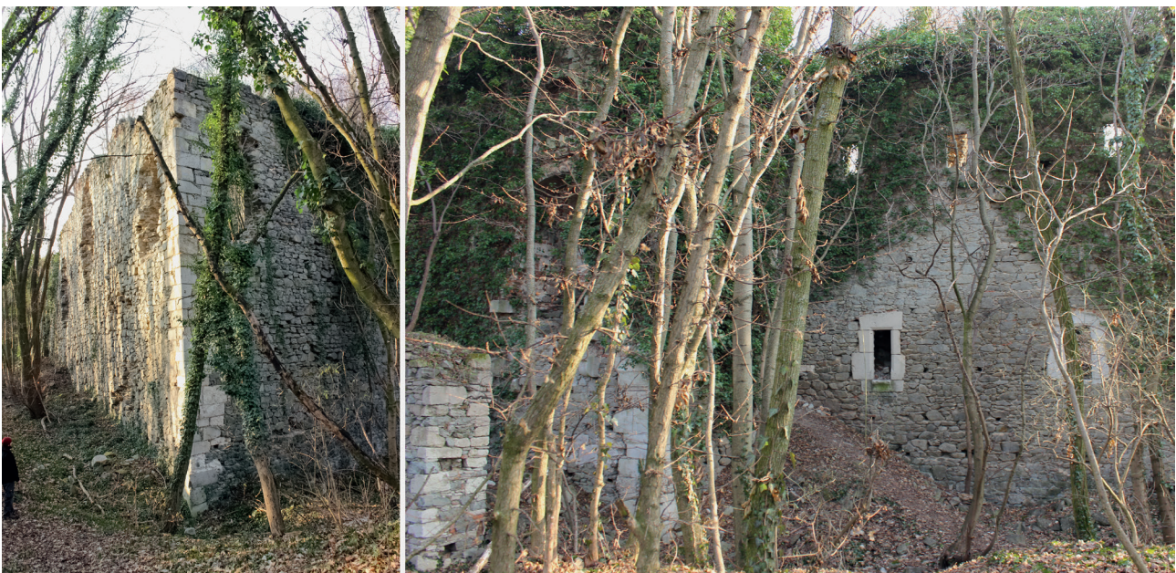
Abb. 32 Die Ruine Scharfeneck im Dezember 2016 mit der nach Osten gerichteten, vom Vorwerk gesicherten Ecke (links) sowie dem an der Nordwestseite befindlichen stark mitgenommenen Torbereich und den schon bei MAYER erwähnten Fenstern (rechts).
