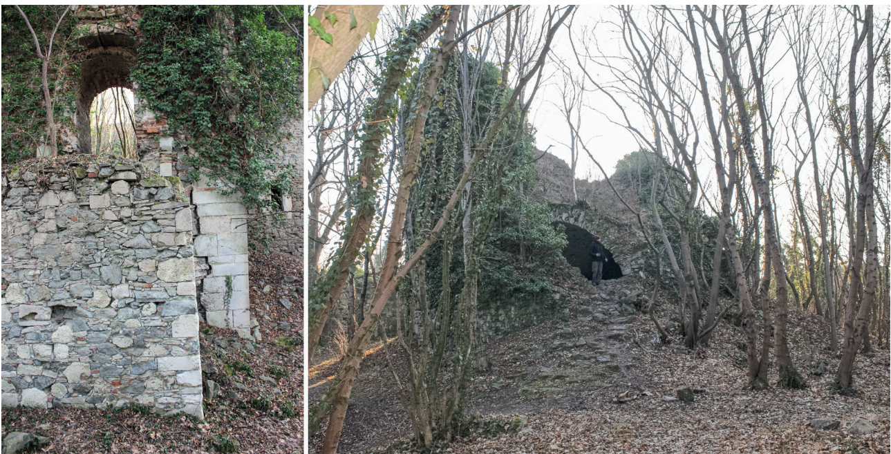
Abb. 33 Der vorgezogene Torbau (links) sowie der 1555 durch einen Blitz zerstörte zentrale Turm mit Zisterne (rechts) im Dezember 2016.
